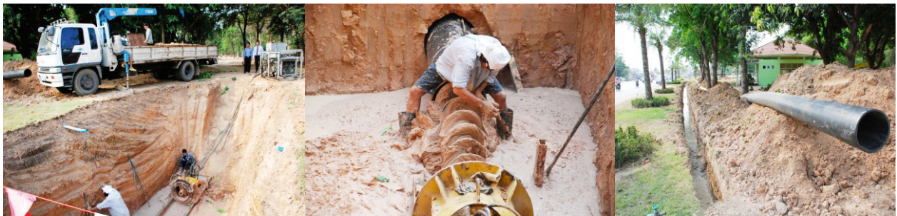
วางท่อส่งน้ำดิบจากแม่น้ำชีและปรับปรุงคลองส่งน้ำดิบ มายังมหาวิทยาลัยมหาสารคาม เขตพื้นที่ขามเรียง
