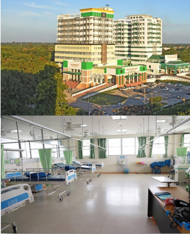
อาคารผู้ป่วยนอก OPD (กำลังก่อสร้าง)
